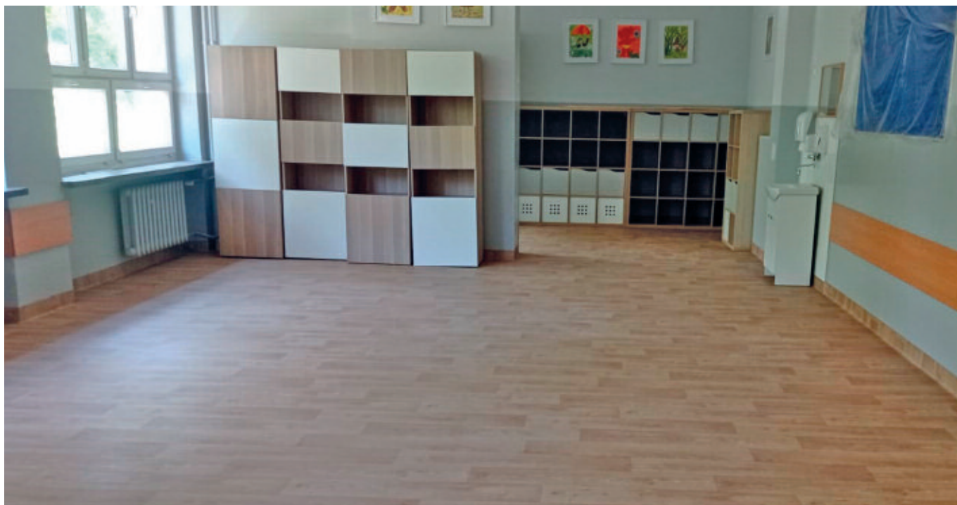
Na zdjęciach remonty placówek oświatowych w roku 2025. Wymiana posadzki w sali lekcyjnej i remont dwóch klatek schodowych w Szkole Podstawowej nr 85 w os. Złotego Wieku
