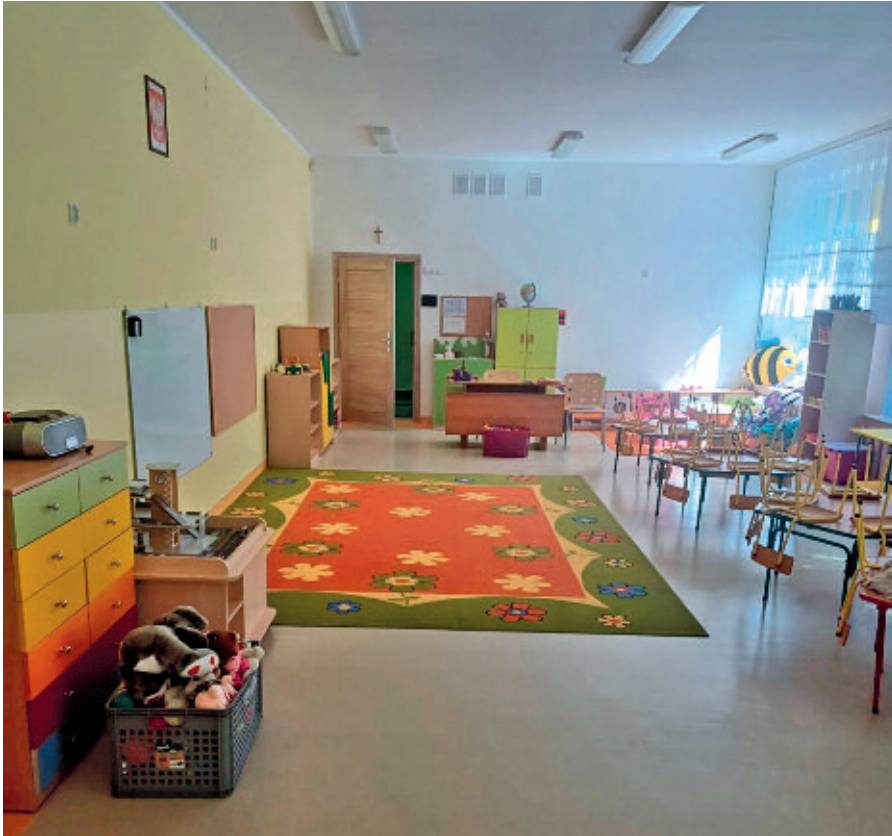
Remont sanitariatów, nowa wykładzina podłogowa w Przedszkolu nr 144 w os. Bohaterów Września
