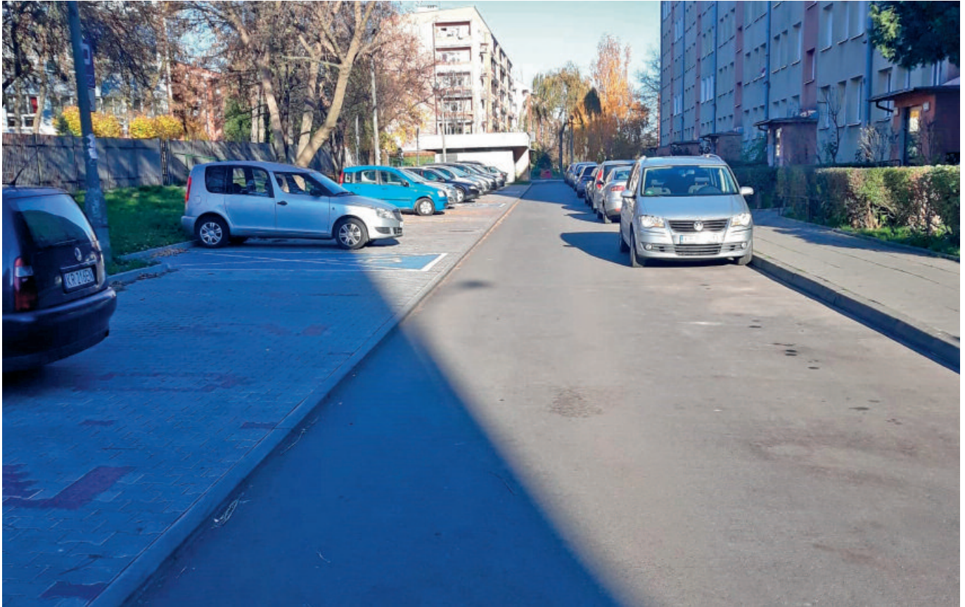
Kontynuacja remontu sięgaczy wraz z miejscami postojowymi przed blokami przy ul. Jadźwingów na osiedlu Piastów
