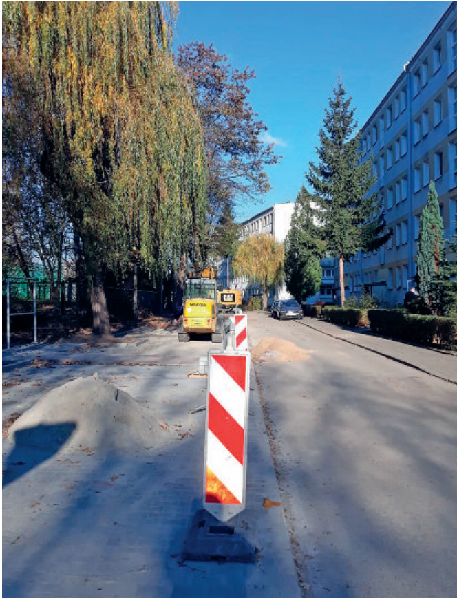
Trwa remont miejsc postojowych wzdłuż bloków nr 29 i 35 na osiedlu Złotego Wieku
