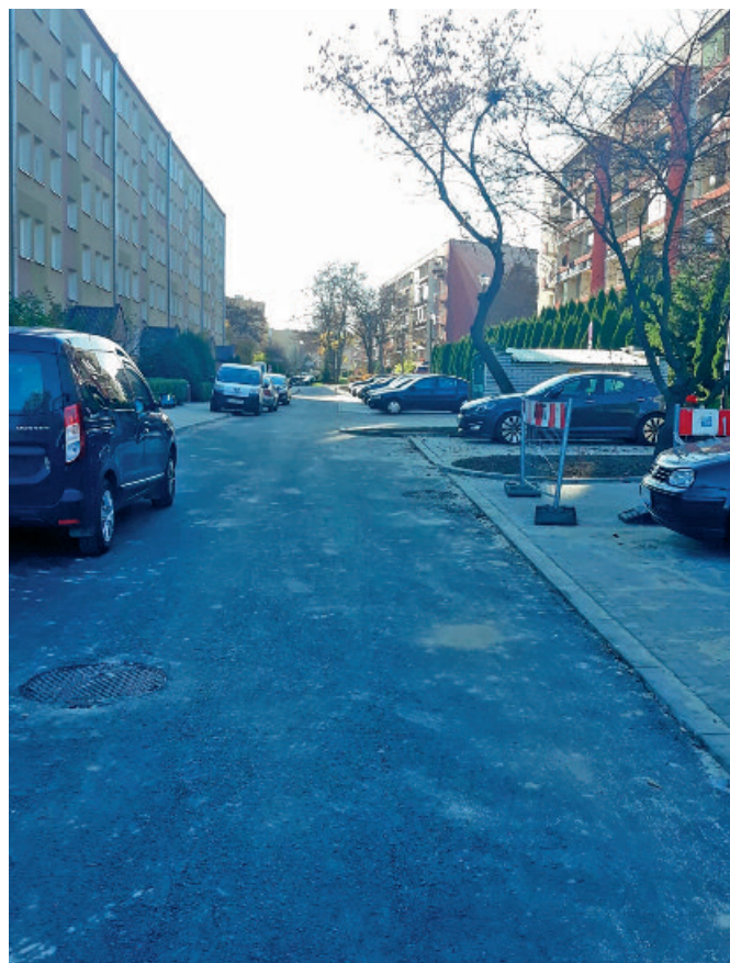
Zakończono modernizację sięgaczy wraz z miejscami postojowymi na osiedlu Piastów nr 24, 26, 28. Inwestycja wymagała budowy zbiornika retencyjnego na wody opadowe.
