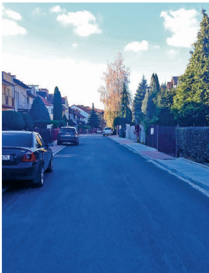
Remont ulicy Korony Polskiej w ramach programu „Nowa Huta dziś”
