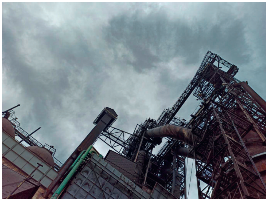
WP nr 5 – widok z zewnątrz
