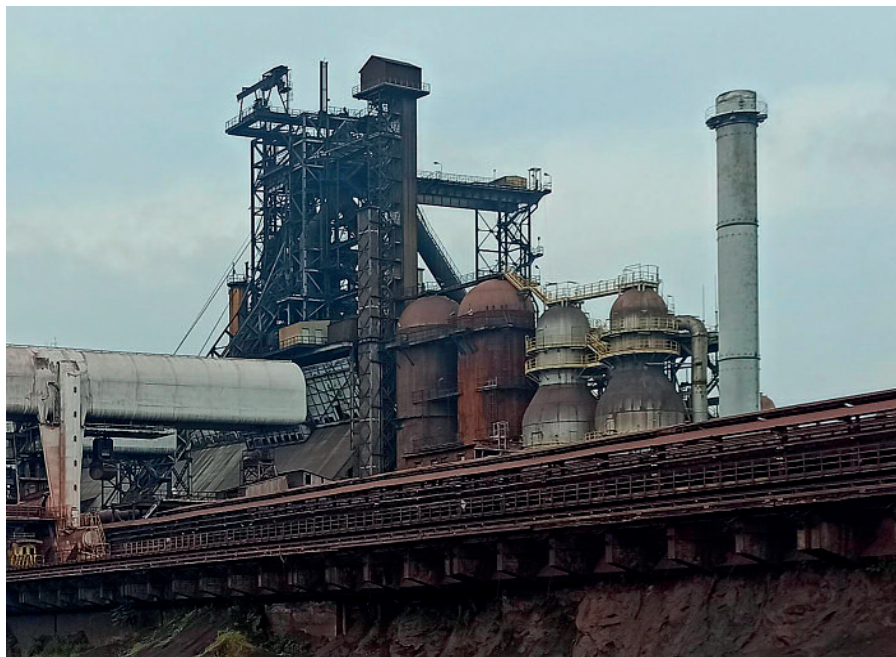
Wielki Piec – ostatni w oddziale AMP S.A. w Krakowie, właśnie zamykany
