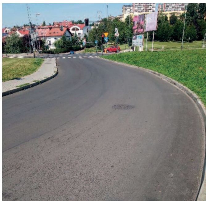
Zmodernizowany fragment ulicy Żaluskich, od skrzyżowania z ul. Jancarza
