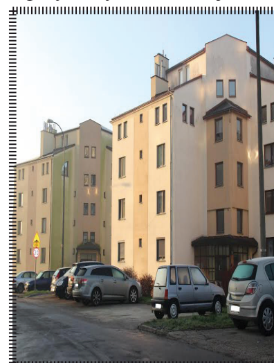
Remont zatoki parkingowej przy ulicy Wawelskiej
