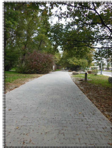
Remont chodnika ul. Wiślicka (os. Tysiąclecia)
