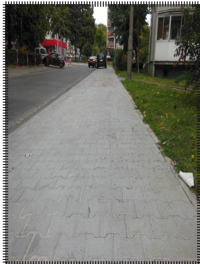
Remont chodnika skręt w ul. Perkuna
