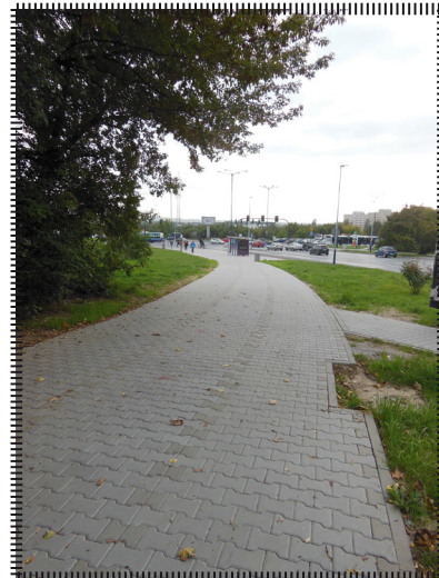
Remont chodnika ul. Wiślicka (os. Kombatantów)
