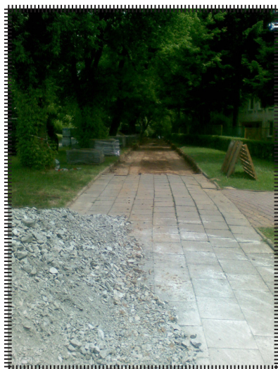
Remont schodów w okolicy kościoła na os. Tysiąclecia
